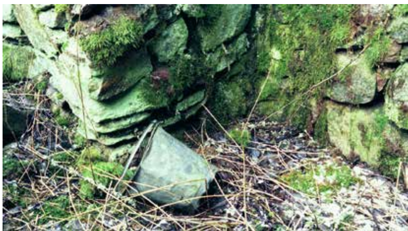
Källargrunden på Olofstorp, byggd av Harry Johanssons far Gunnar i Vilandsås som en potatiskällare cirka 1930 av stenar från det rivna boningshuset.
